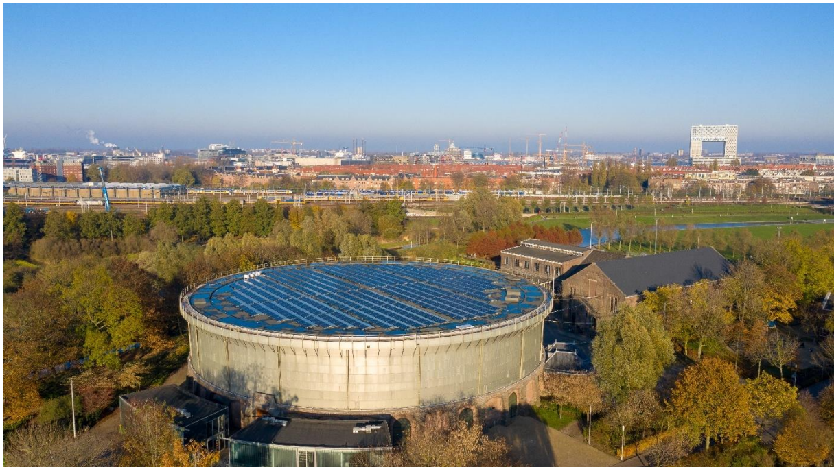
Foto: Westergasfabriek Ecostrroom, 150 Amsterdamse huishoudens die gezamenlijk energie opwekken. De 1024 panelen zijn geplaatst door de Zonnefabriek in de zomer van 2018.
